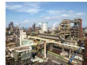
写真4-4 竣工後の大分第5コークス炉外観
