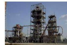
写真4-1 ベンチプラント試験装置の概観
